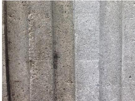
*Betonmauer, rechts Hydro C-44, 6 Monate nach Anwendung*
